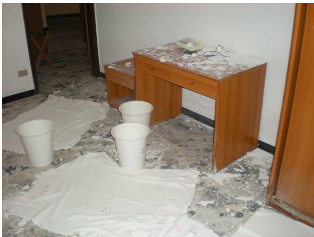
DANNI PER INFILTRAZIONI
